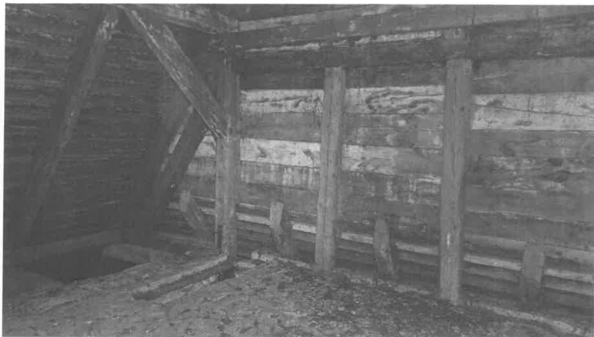
Fot. 16. Konstrukcja ściany szczytowej prezbiterium. Po lewej stronie widoczne poszycie z deskowaniem połąć północnej. Na posadzce widoczny otwór, przez który widoczna jest ściana zewnętrzna wykonana z desek. (wyk. Ł. Szatanek)
