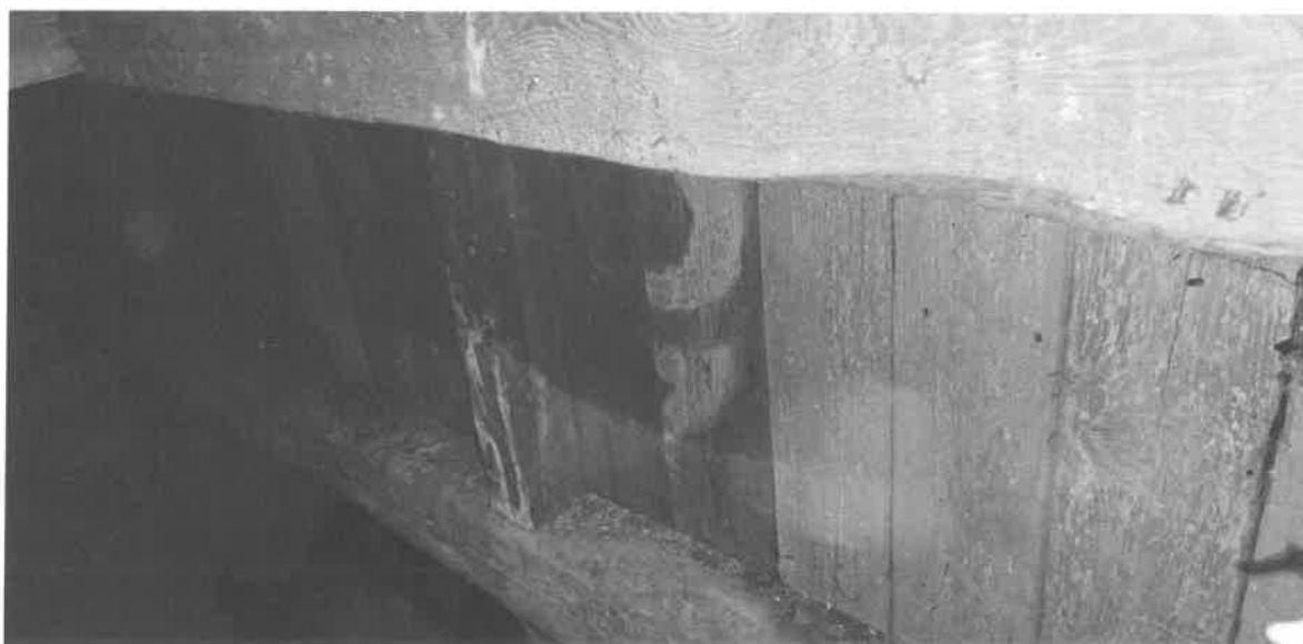
Fot. 20. Zdjęcie przedstawia pozorną ścianę zewnętrzną. Pionowe deski są podkładem dla tynku zewnętrznego. Jest to pas między okapem dachu głównego a początkiem (kalenicą) dachu zakrystii. Belka dolna daje początek dachowi zakrystii. (wyk. Ł. Szatanek)
