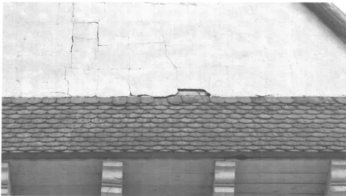
Fot. 6. Detal ściany szczytowej – z popękanym tynkiem na podłożu drewnianym . (wyk. Ł. Szatanek)
