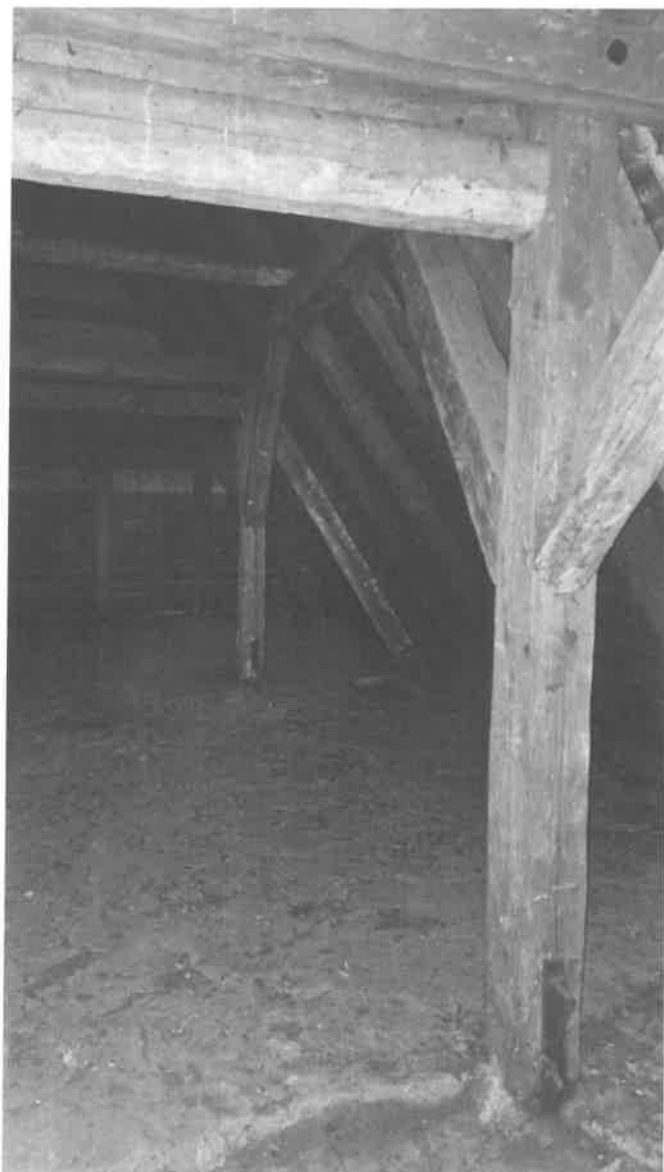
Fot. 15. Widok więźby dachowej w kierunku prezbiterium. Zdjęcie robione na granicy prezbiterium i nawy. Nad nawą odkryte deski na posadzce w części prezbiterialnej pokryte zaprawą grub. 3-4 cm. Na wprost widoczna ściana szczytowa drewniana. (wyk. Ł. Szatanek)
