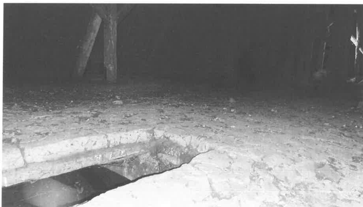
Fot. 17. Widok pokazujący warstwy posadzki poddasza. (wyk. Ł. Szatanek)
