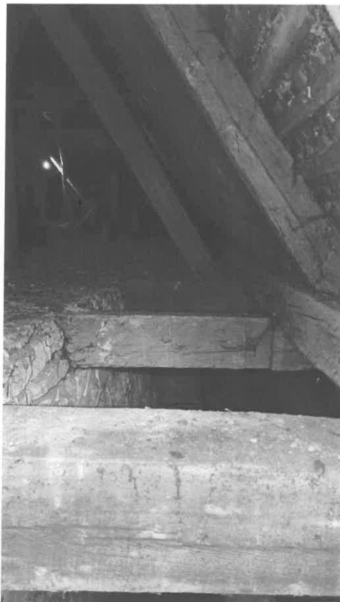
Fot. 18. Widok na główne podwaliny podtrzymujące murlatę nad pustą przestrzenią wynikającą z przesunięcia ścian prezbiterium. (wyk. Ł. Szatanek)
