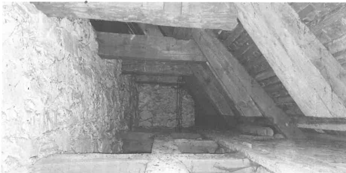
Fot. 19. Widok na pustą przestrzeń wewnątrz budynku. Na wprost i po lewej stronie mur magistralny nawy głównej i prezbiterium. Widoczne jego pomniejszenie w części prezbiterialnej. U góry zdjęcia belki pod murłatami. Krokwie widoczne są po prawej stronie. Deski po prawej stronie leżące poziomo to zewnętrzne przykrycie przestrzeni międzyokapowej. Dolne belki to wsporniki zdobione na zewnątrz i malowane na brązowo. Po prawej poniżej dolnych belek zaczyna się ściana pionowa zewnętrzna – drewniana. (wyk. Ł. Szatanek)
