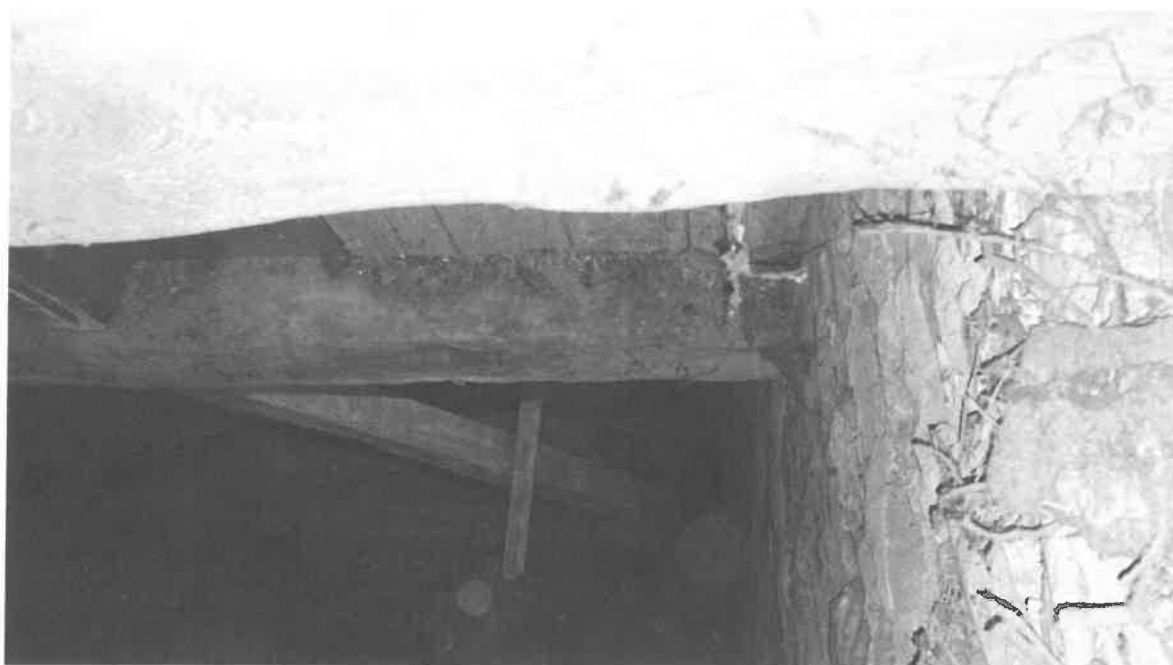
Fot. 21. Widoczna wolna przestrzeń pod sztuczną ścianą będącą stropem zakrystii. (wyk. Ł. Szatanek)
